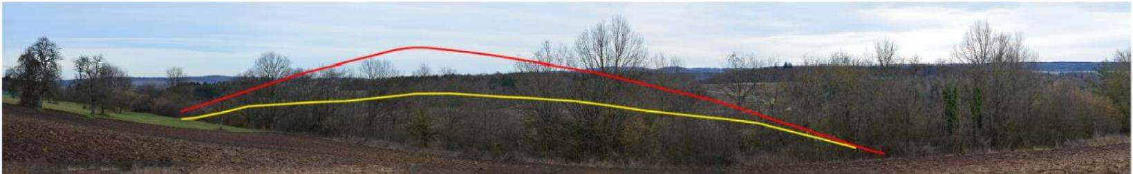
Bild 2: Darstellung des Höhenprofils anhand Geländelinien (blau = aktuelles Gelände; gelb = genehmigte Erweiterung; rot = zusätzlich geplante Erweiterung)
