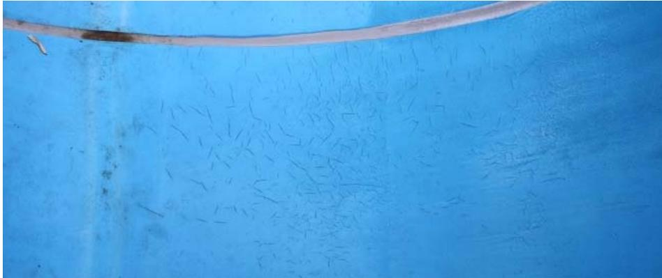
Beispiel der Rutschbahnschalen aus GFK mit zahllosen, altersbedingten Rissen
